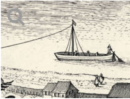
Treideln: Neckaraufwärts wird ein Kahn getreidelt, von der Mastspitze führt ein Seil zu dem Pferd und dem Schiffsreiter auf dem Leinpfad.
