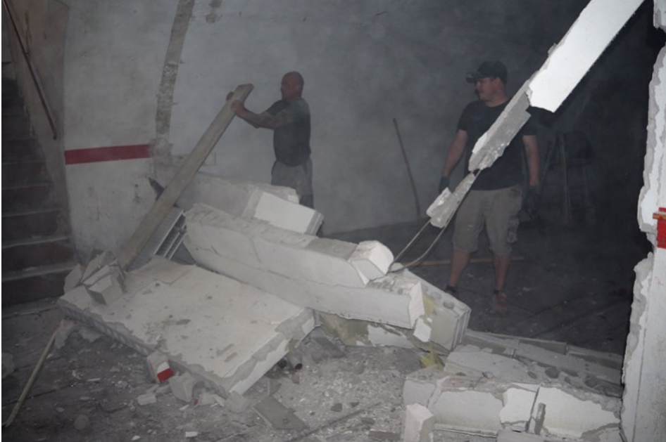
Oben: Abbruch der Zwischenwand und Freilegung des Gewölbes. Unten: Der Keller nach Freilegung des Gewölbes und Herstellung des ursprünglichen Zustandes 2017/2018. Bilder: Christoph Hüther.
